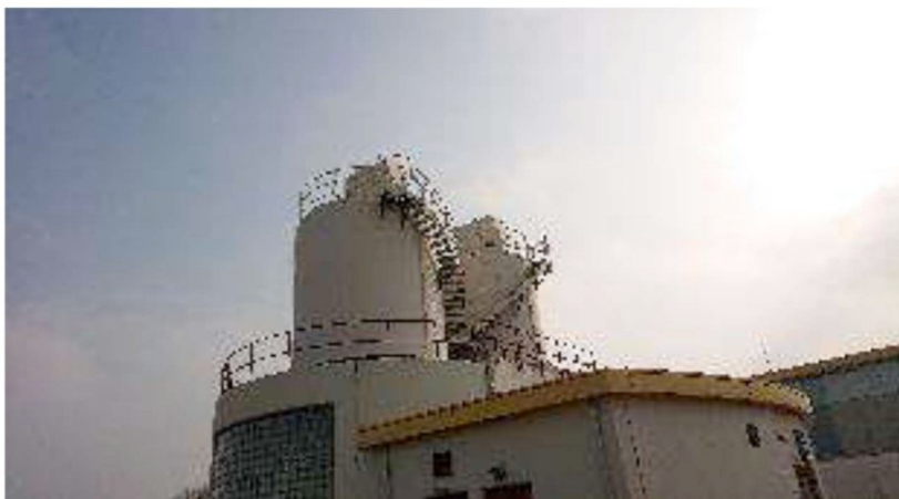
Locatie Poederkoolinstallatie Scheveningen.
