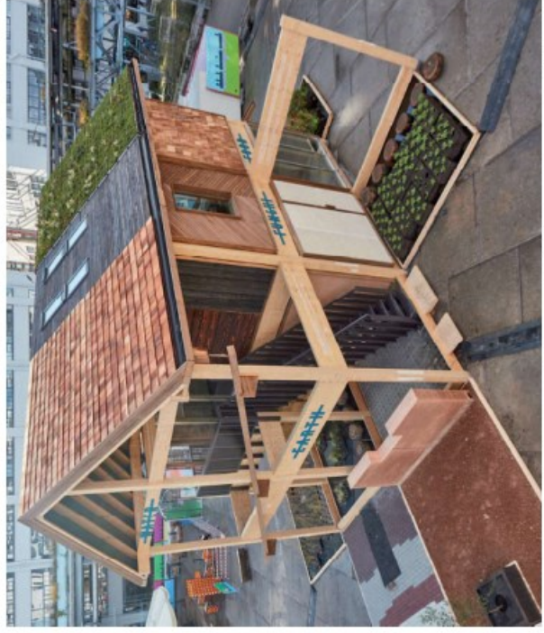
the exploded view: gebouw dat bijna 100 verschillende biobased bouwmaterialen toont
