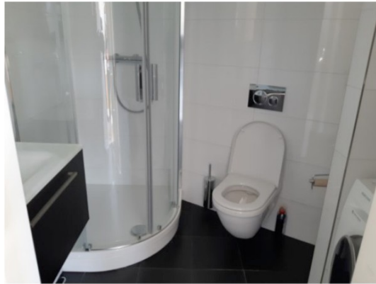
Badkamer met toilet
