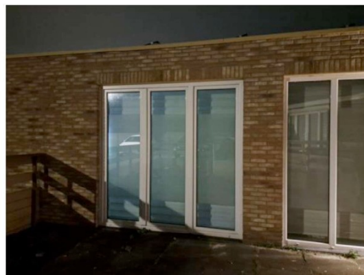
Gevel straatzijde bijgebouw
